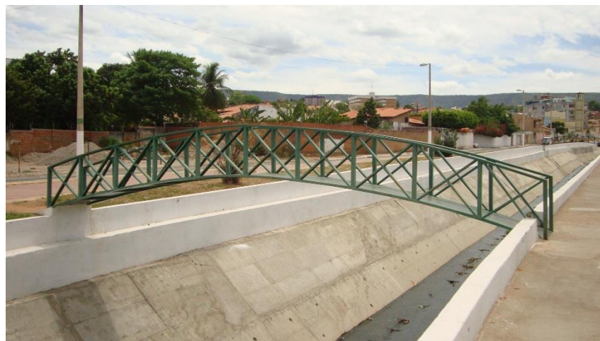
Figura 3 - Passarela metálica reconstruída sobre o canal do rio Grangeiro, em 2014, na cidade de Crato/CE. Fonte: SEDEC/MI.
