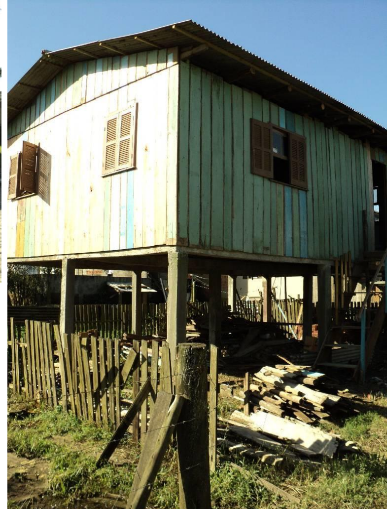
Figura 68: Ponto 14 - adaptação para enfrentamento de enchentes, comunidade Barranca.
