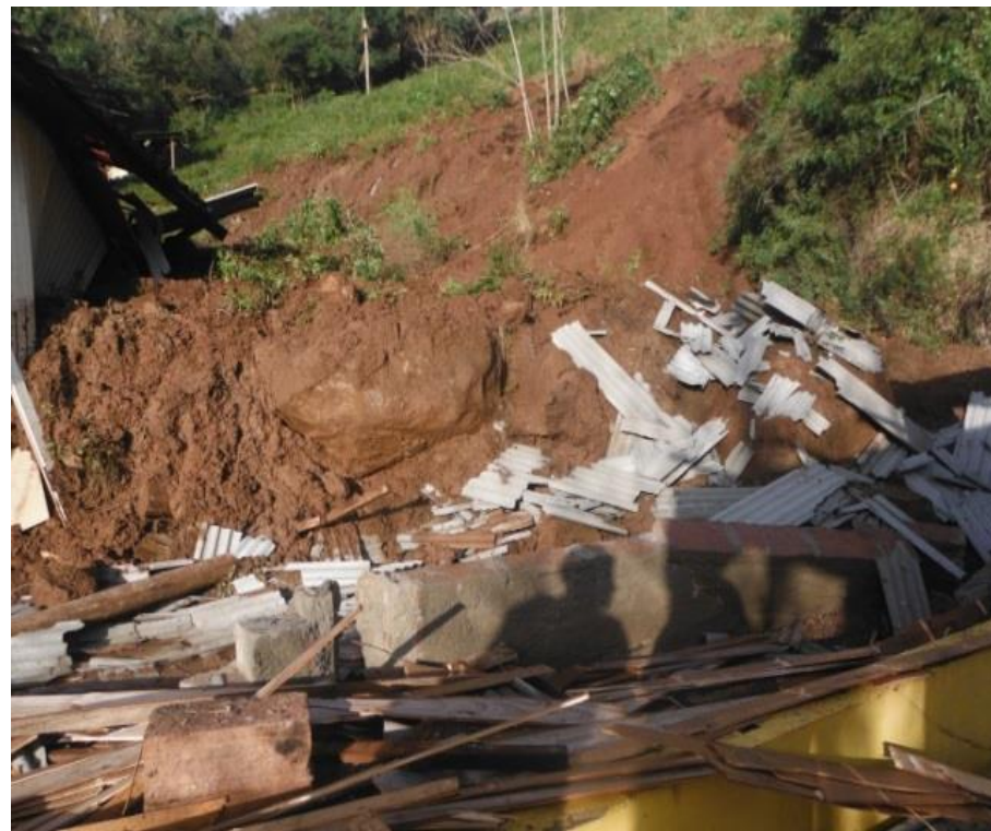
Deslizamento Bairro Viaduto 20/07/2015
