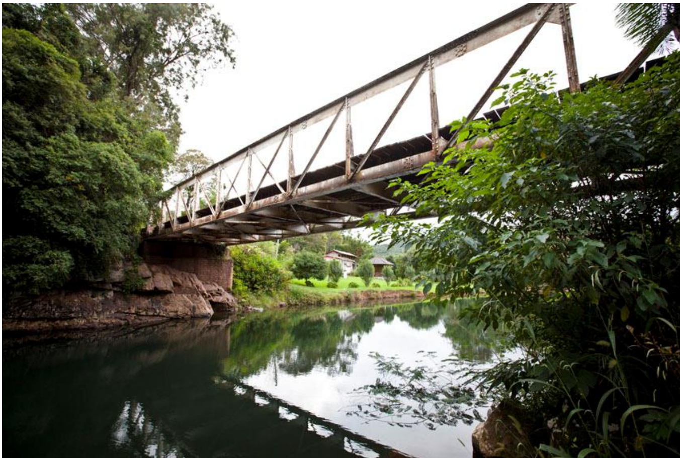
Ponte Branca - Lajeadozinho/Caraá
